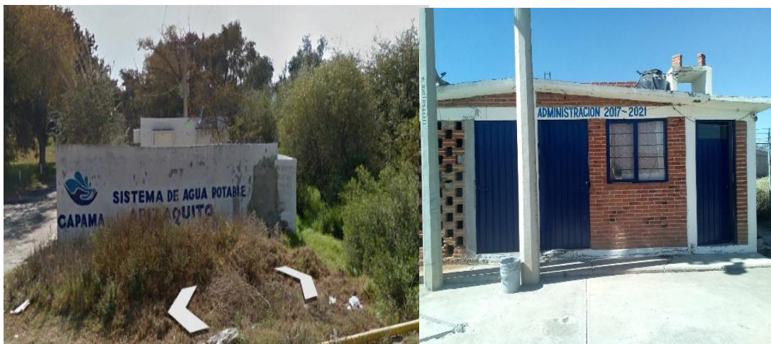
Foto 19. Sistema de agua potable "Apizaquito"
