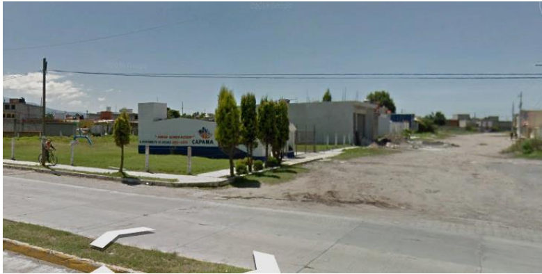
Foto 20. Sistema de agua potable "Nueva Generación"
