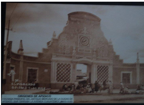
“Fachada principal del antiguo mercado de la ciudad de Apizaco”
